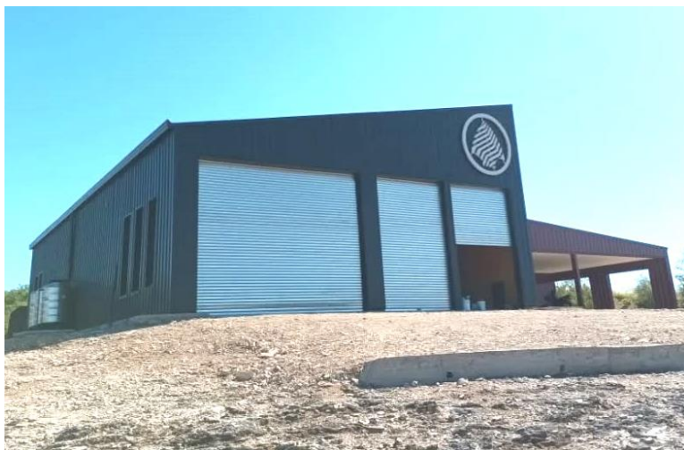
Figura 5. Centro operativo y galpón en la zona de uso especial.
